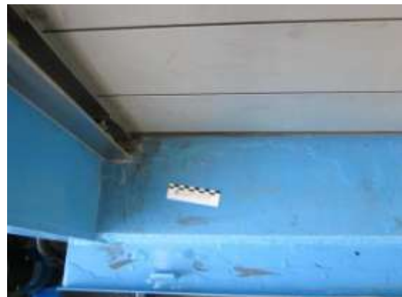
Bild 5-6: Unterer Anschluss der Führungsschiene und Sohlendichtung
