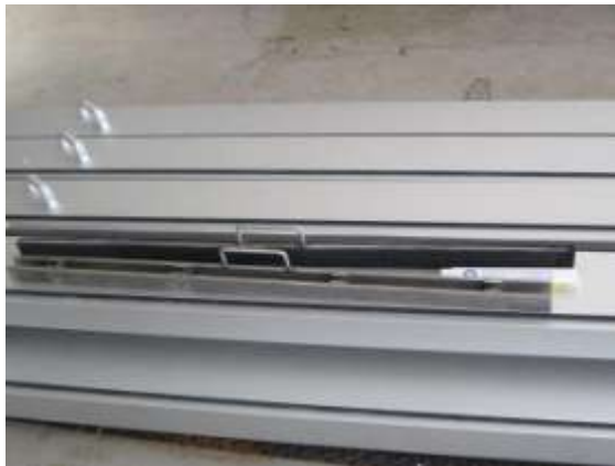
Bild 5-9: Auf Damm balkenelemente gelagerte Pressschieber und Dichtschieber
