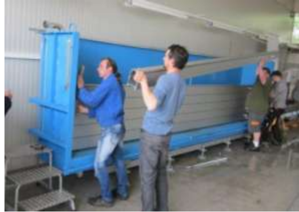
Bild 6.2-2: Einbau Dammbalken
