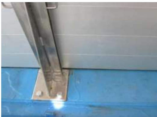
Bild 5-5: Unterer Anschluss der Mittelstütze
