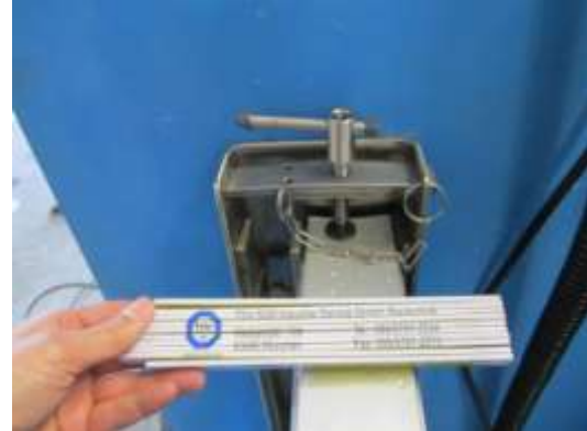
Bild 5-2: U-Aufnahme und Dammbalken mit Vertikalspanner
