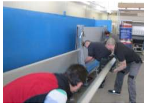
Bild 6.2-4: Einbau Dammbalken
