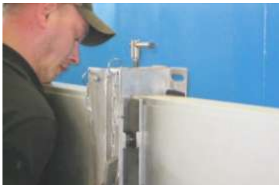
Bild 6.2-5: Fixierung der Dammbalken mittels Vertikalspanner
