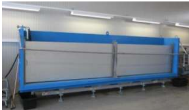
Prüfbox nach dem Einbau des Hochwasserschutzsystems
