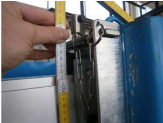
Bild 5-3: U-Aufnahme und Dammbalken mit Knebelschraube
