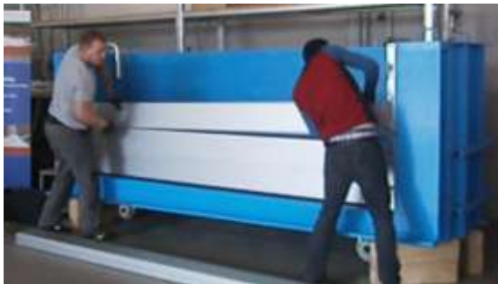
Bild 6.2-3: Einbau Dammbalken
